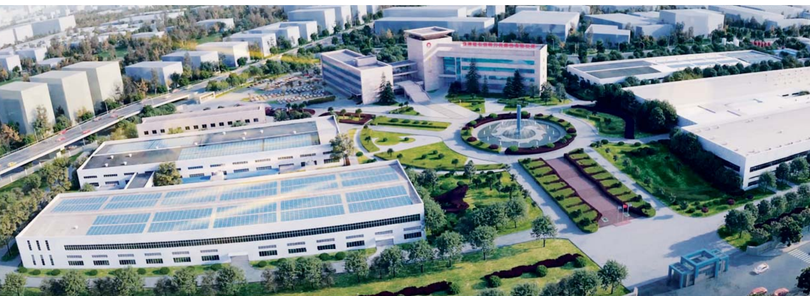
Штаб-квартира ZCC Cutting Tools, г. Чжучжоу, Китай
